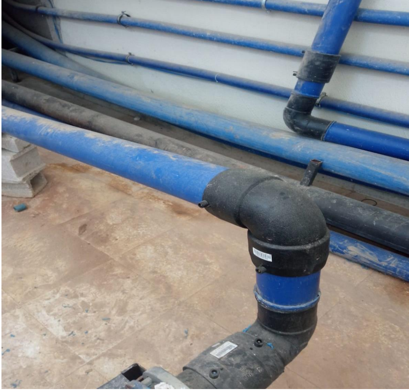
14-Üniversitemiz Merkez, Karataş ve Mercidabık Kampüslerindeki Sirkülasyon Motopomp Bakım Onarım İşi
